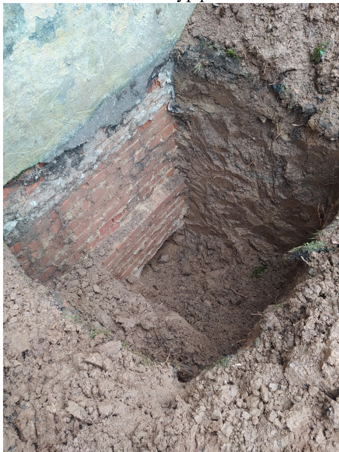
Фото №34. Вид на шурф №1. Внешняя стена здания.
